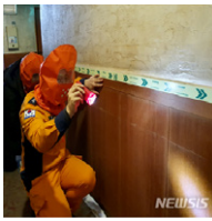
출처: 광주 북부소방, 숙박업소에 '피난장치 3종 세트' 설치 (뉴스시스, '20.03.11.)
