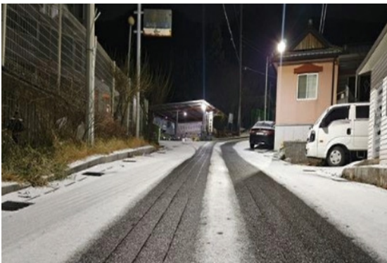
출처: 고원도시 태백시, 겨울철 도로·인도 열선 설치 운영 (연합뉴스, '25.1.16)
