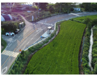
출처: 익산시, 황등면 구자마을 앞 위험도로 구조개선 공사 완료 (전민일보, '24.09.05.)
